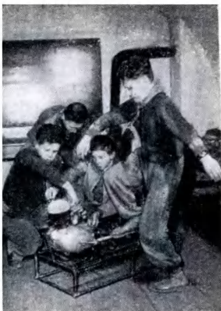
Юные техники пионерского дома в Гораждёвицах испытывают свой моторный агрегат, на котором они изучают действие двухтактного двигателя.
